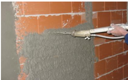
Aplicação por projeção
