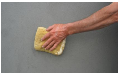
Execução do acabamento areado
