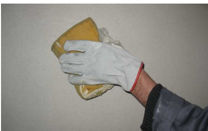
Execução do acabamento areado
