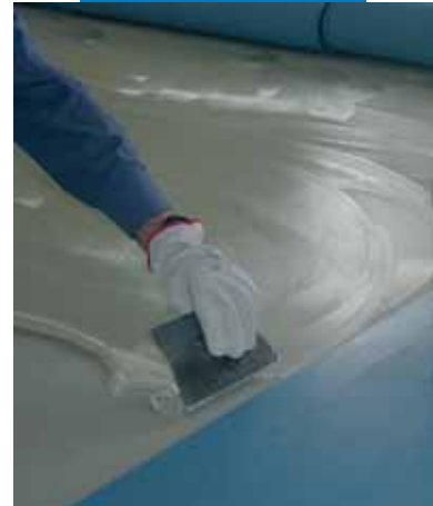
Aplicação de Ultrabond Eco V4 SP - Lar da Terceira Idade de San Martino - Itália
