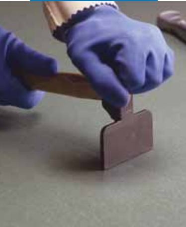
Pressionar do revestimento sobre a junta
