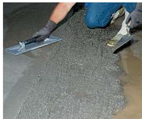
Aplicação da betonilha aditivada com Idrosilex Líquido
