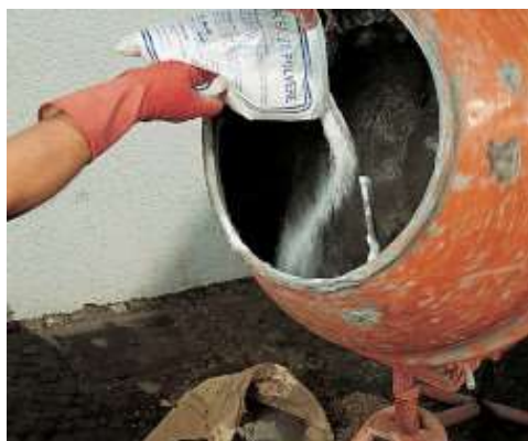
Preparação da argamassa hidrófuga aditivada com Idrosilex Polvere
