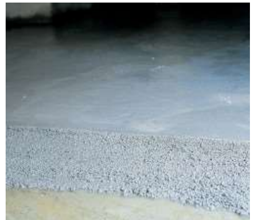
Betonilha aditivada com Idrosilex
