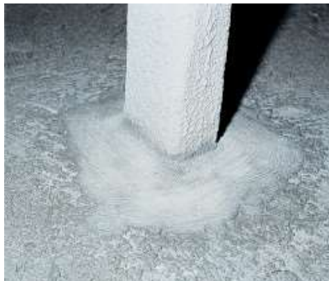
Exemplo de pilar impermeabilizado com Idrosilex
