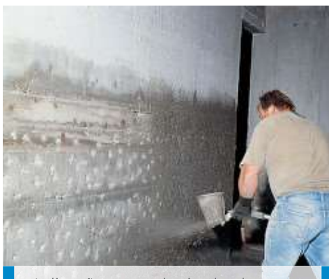
Aplicação com pulverizador de copo da 1ª camada de argamassa aditivada com Idrosilex Líquido
