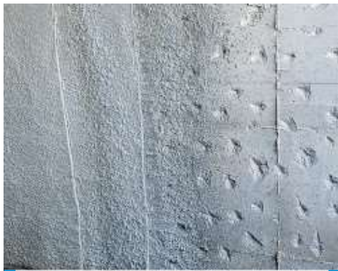
Aplicação de argamassa de reboco aditivado com Idrosilex sobre betão rugoso
