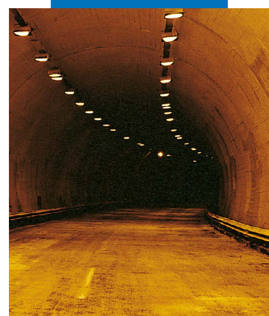
Aplicação por projeção de Planiseal 88 branco na galeria de uma autoestrada
