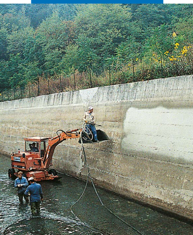
Aplicação por projeção de Planiseal 88 num canal hidrelétrico
