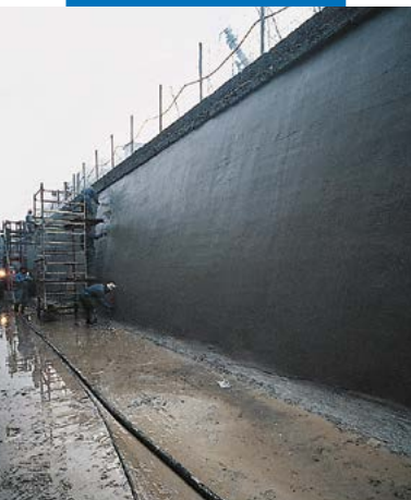
Canal hidroelétrico Bertini - Robbiate (Como): vista do conjunto
