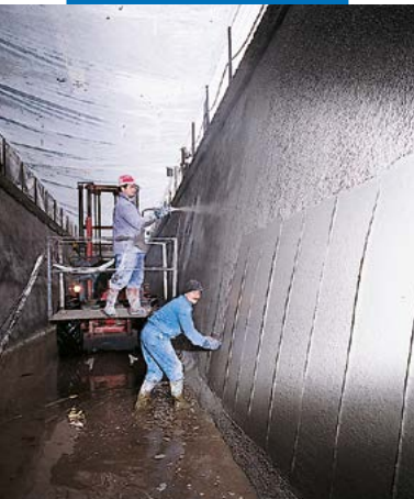
Canal hidroelétrico Bertini - Robbiate (Como): acabamento com espátula
