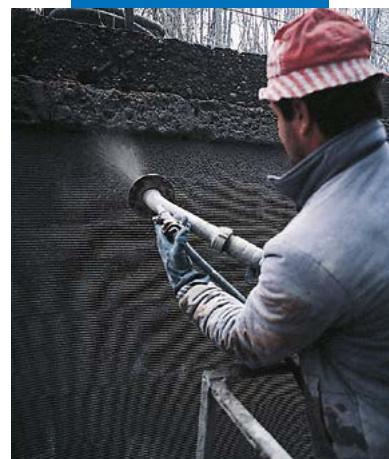
Canal hidroelétrico Bertini - Robbiate (CO): aplicação por projeção
