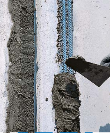
Aplicação com colher de pedreiro
