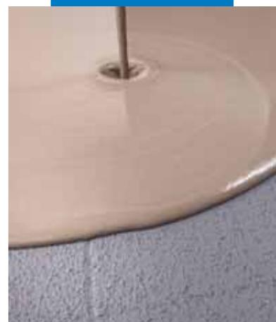
Aplicação da argamassa de regularização autonivelante **Ultraplan** enxuto e aplicado sobre um velho pavimento
