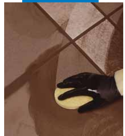
Limpeza e acabamento das juntas com esponja
