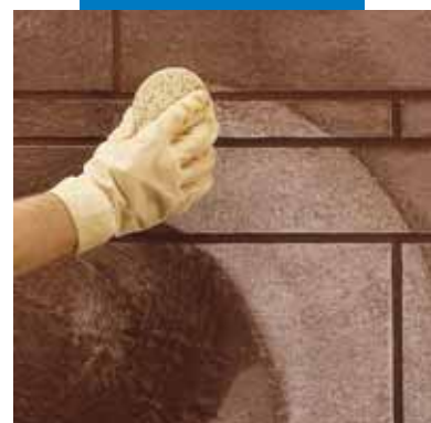
Limpeza e acabamento das juntas com esponja
