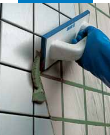
Aplicação do Ultracolor Plus em parede com talocha de borracha
