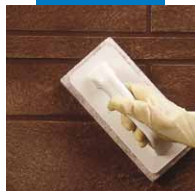
Limpeza das juntas com Scotch-Brite® (com produto parcialmente endurecido)
