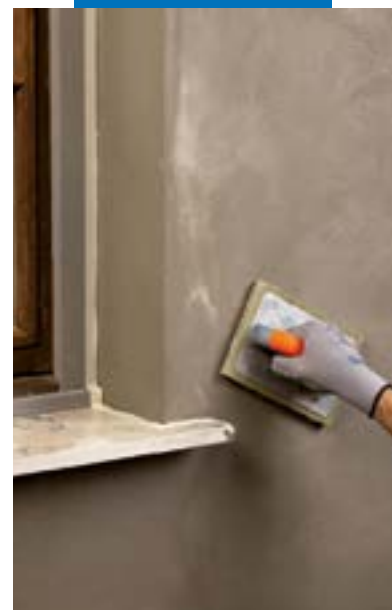
Aplicação de Planitop 210 com taloça
