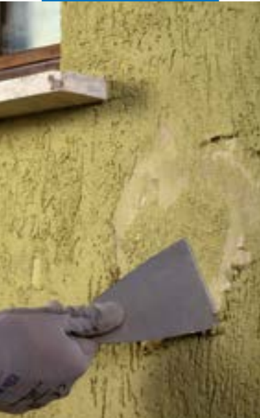
Remoção do revestimento plástico não aderente
