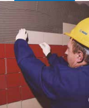
Assentamento de cerâmica de cima para baixo
