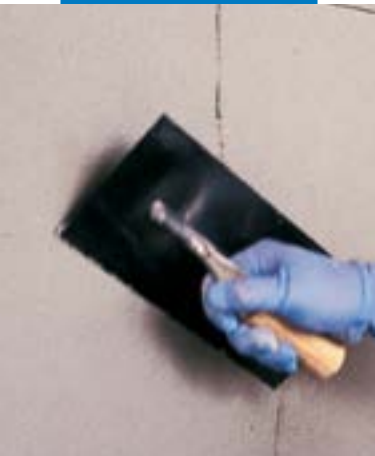
Aplicação de Planitop 560 com espátula metálica
