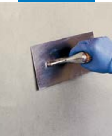
Regularização da superfície de Planitop 560 com espátula metálica
