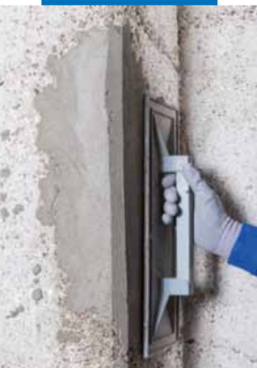
Regularização com talocha do Planitop Rasa & Ripara R4
