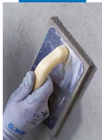
Afagamento do Planitop Rasa & Ripara R4
