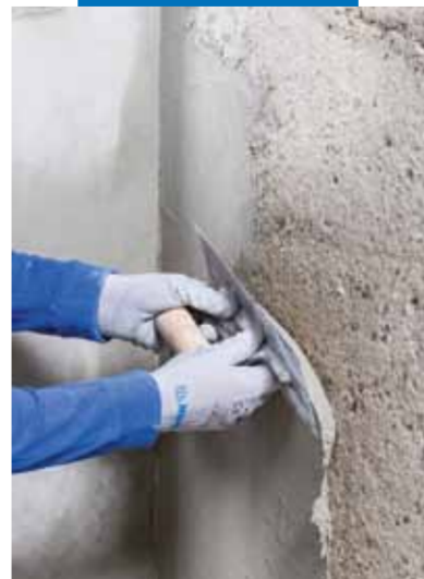
Aplicação com espátula do Planitop Rasa & Ripara R4
