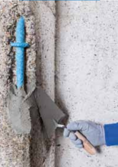
Aplicação com colher de pedreiro do Planitop Rasa & Ripara R4
