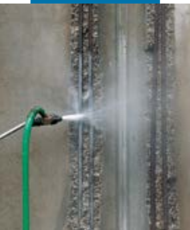
Decapagem dos ferros com jato de areia húmida
