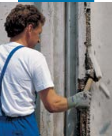
Demolição do betão degradado
