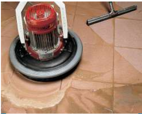
Acabamento de pavimento em porcelanato com monoescova e régua
