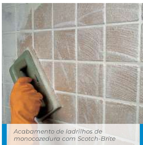
Acabamento de revestimento em monocozedura com esponja
