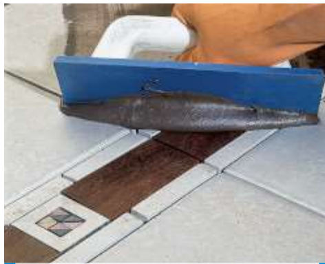
Execução de juntas em pavimento cerâmico inserções em madeira com espátula
