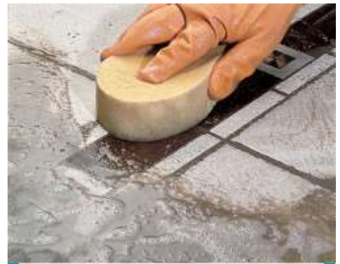
Acabamento de pavimento cerâmico com inserções em madeira com esponja
