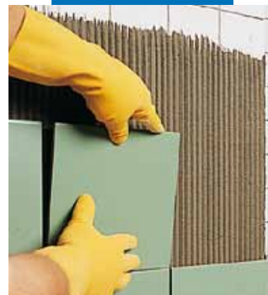
Assentamento sobre ladrilhos antigos
