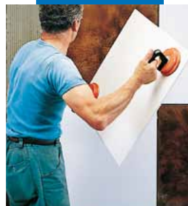
Assentamento de KERAION em paredes
