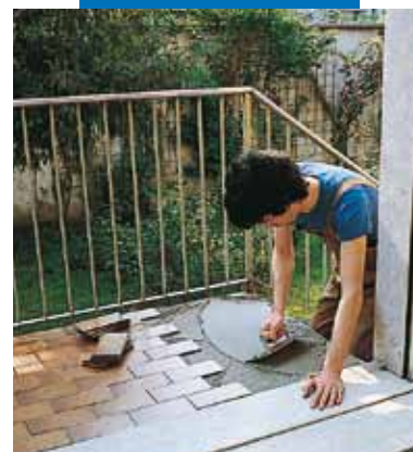
Regularização impermeabilizante e sucessivo assentamento com Kerabond T + Isolastic
