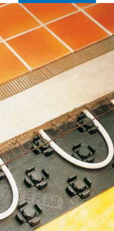
Assentamento de cerâmica sobre pavimentos radiantes
