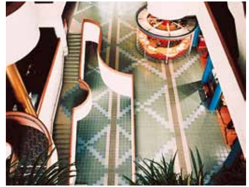
Grés porcelânico aplicado com Kerabond T + Isolastic - Civic Center - North York Ontario (Canada)
