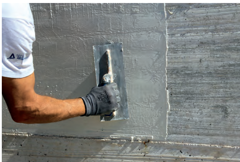
Reparação estética de betão arquitectónico
