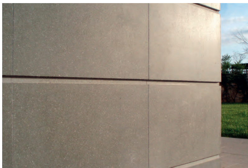
Revestimento exterior de edifício
