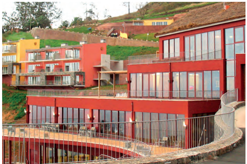
Revestimento exterior de edifício habitacional
