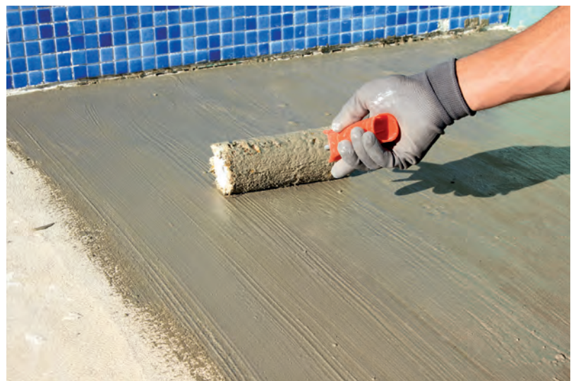
Impermeabilização de piscina
