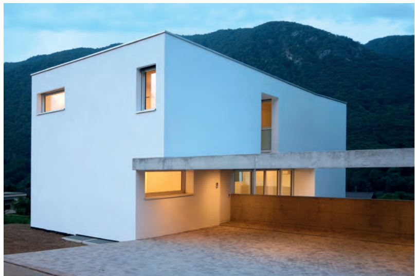
Revestimento de moradia com acabamento areado fino
