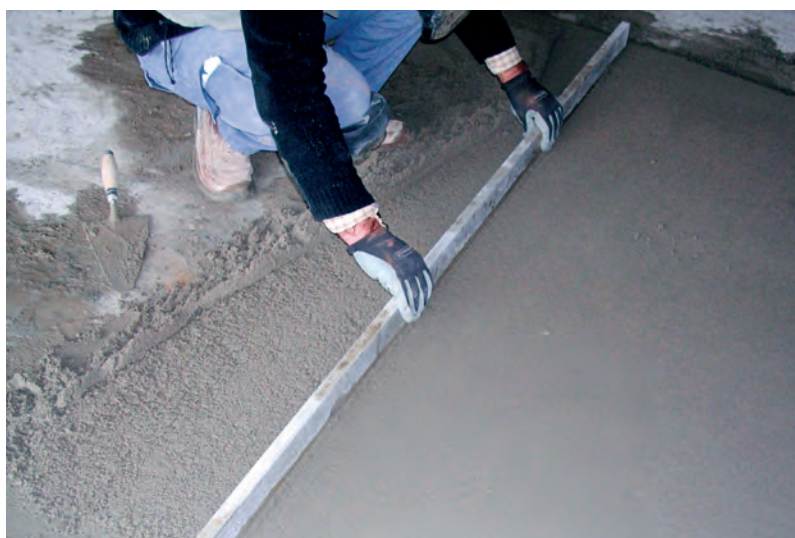
Regularização da BETONILHA
