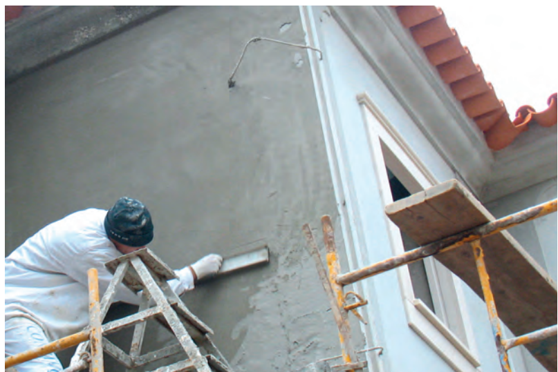
Processo de corte da superfície do reboco RHP Korte Exterior
