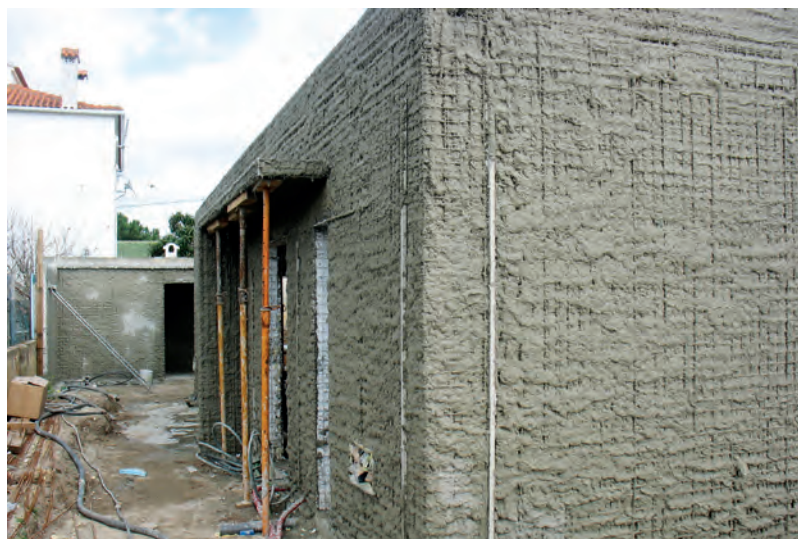
Aplicação de SecilTEK MICROBETÃO 25 projectado em moradia unifamiliar
