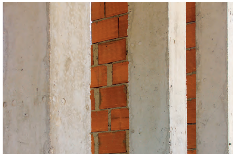
Estrutura em SecilTEK Betão Cinzento
