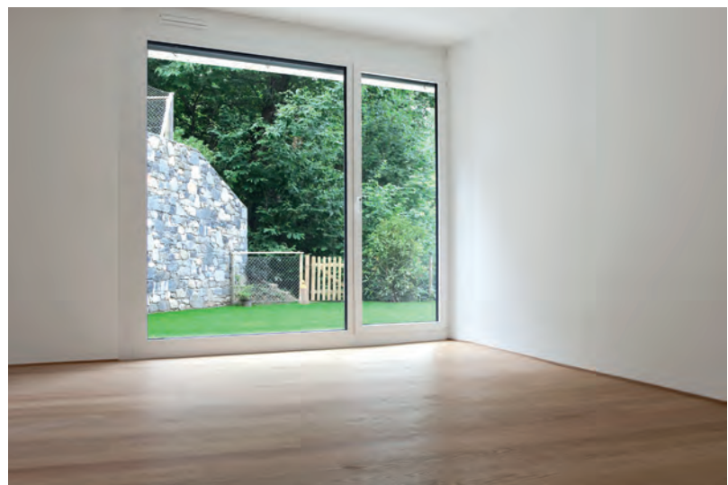
Acabamento liso em paredes e tectos interiores
