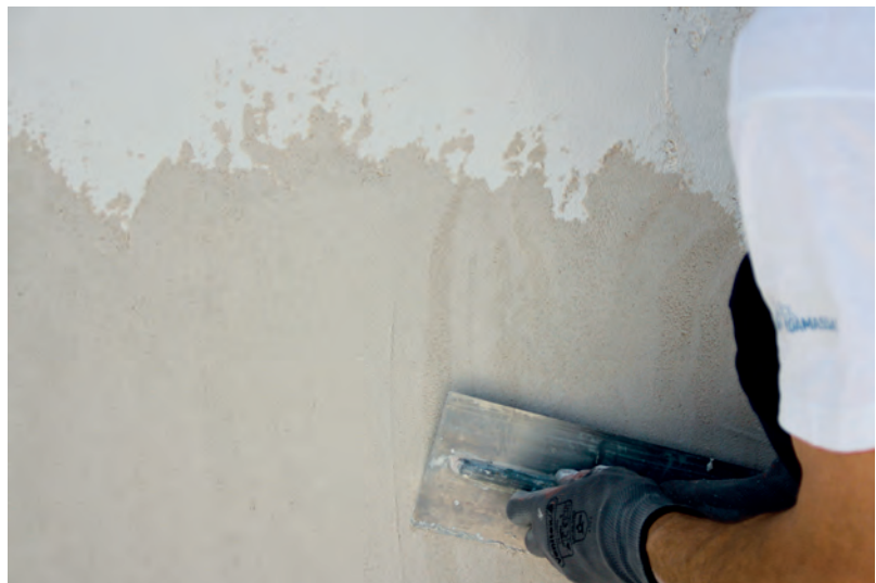
Aplicação em obra de FLEXDUR sobre reboco ISODUR
