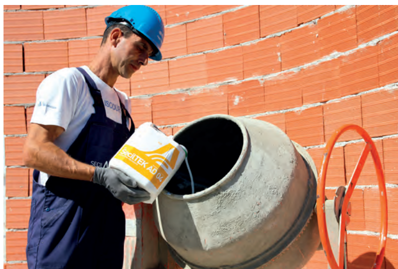
Preparação de argamassa com SecilTEK AD 04
