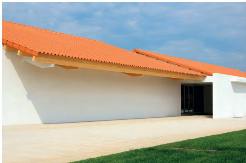
Revestimento em sistema de dupla camada, com acabamento FINIDUR branco
