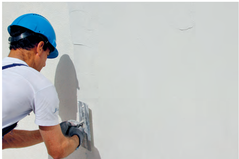
Aplicação em obra de FIXDUR sobre reboco ISODUR
