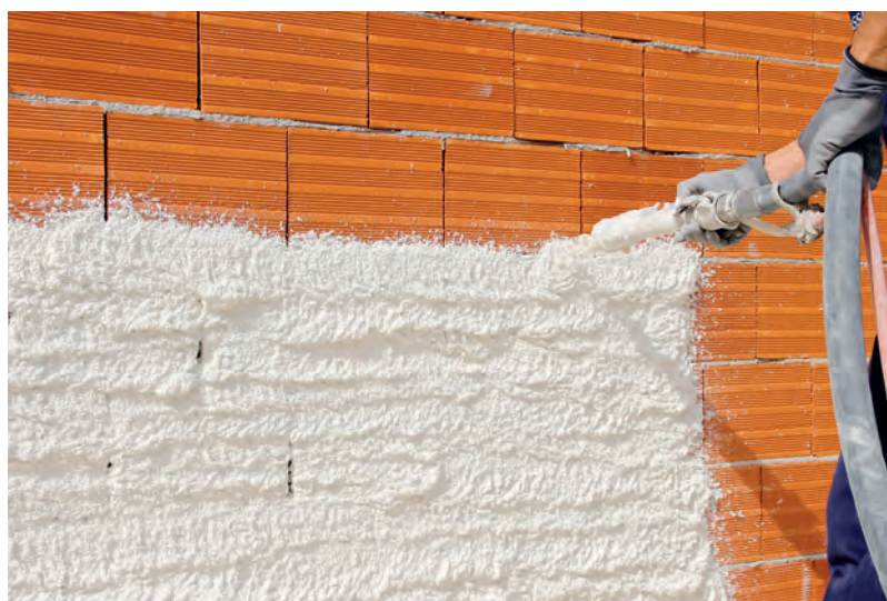
Aplicação do sistema de isolamento térmico ISODUR pelo exterior
