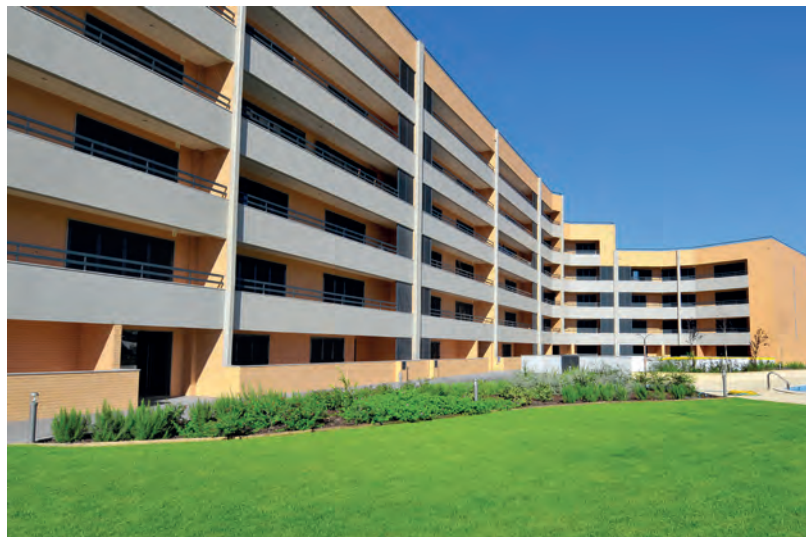
Revestimento exterior de edifício habitacional
