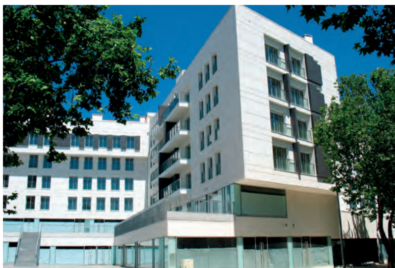
Revestimento exterior de edifício habitacional
