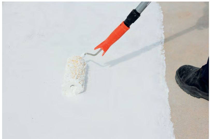
Impermeabilização de cobertura com o SecilTEK HidroSTOP Elástico de cor Branco
