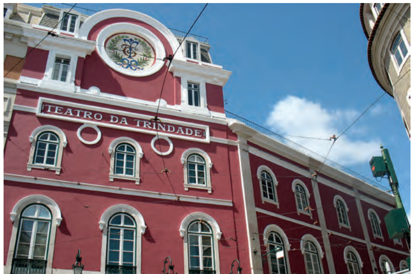
Reabilitação da fachada do Teatro da Trindade, em Lisboa
