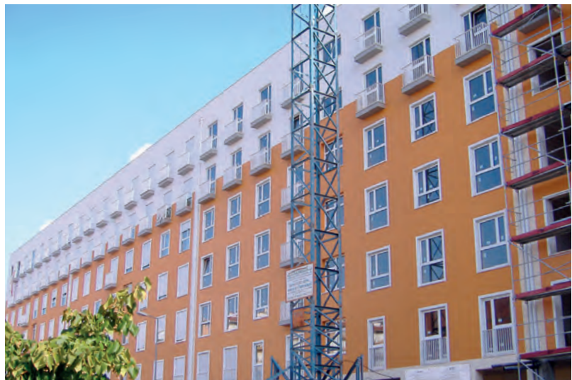
Revestimento exterior em edifício habitacional
