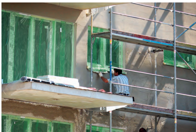
Isolamento térmico pelo exterior de edifício de habitação
