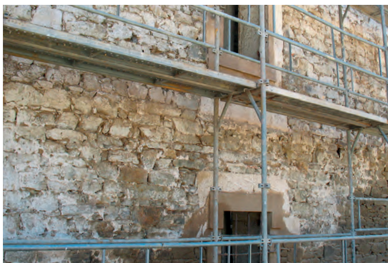
Reabilitação de alvenaria antigas com humidades ascensionais
