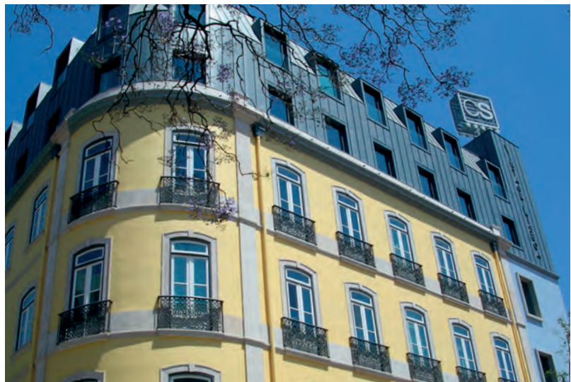
Reabilitação de fachada de hotel
