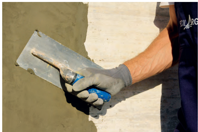
Impermeabilização de tanque em betão
