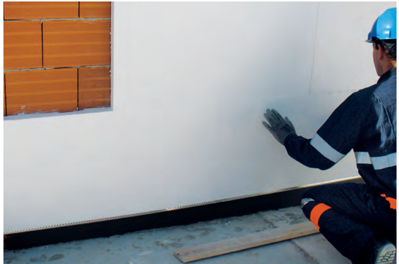
Aplicação de ADHERE Vit FibrasFLEX
