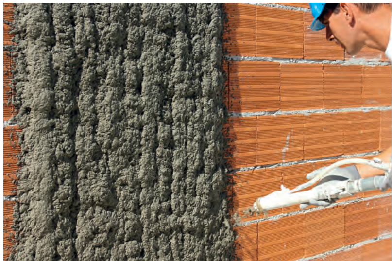
Projecção de elevado rendimento do Reboco ecoCORK
