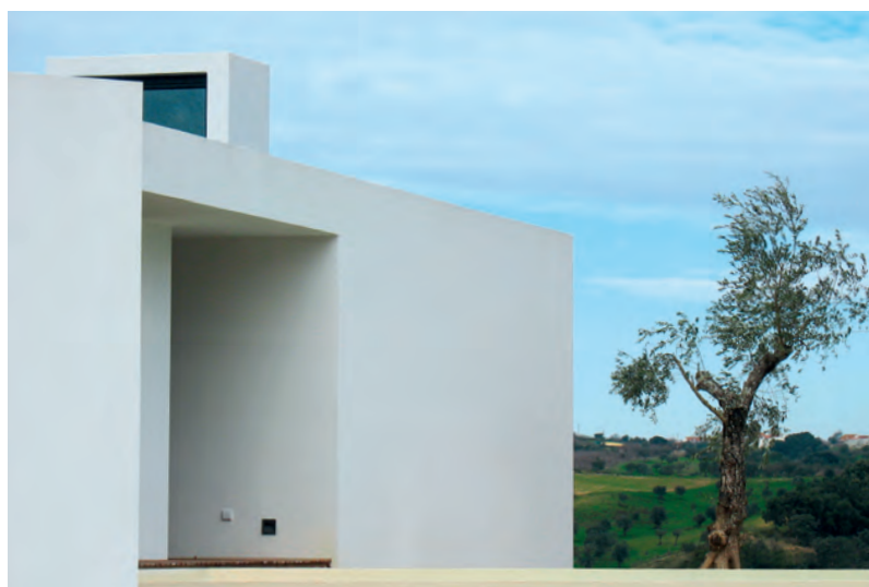
Acabamento decorativo acrílico REVDUR em moradia
