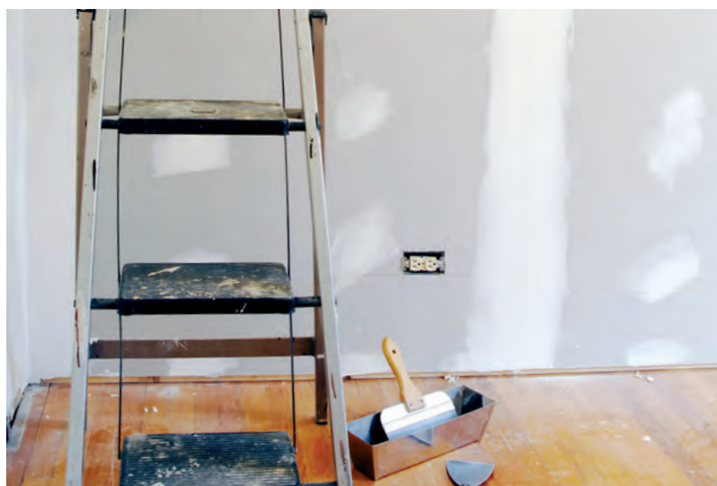
Renovação de casa de banho
