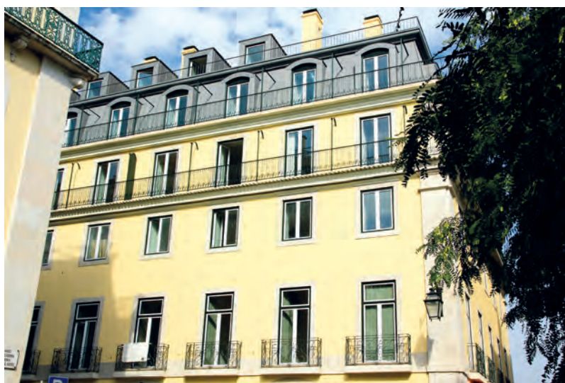
Acabamento à base de cal na reabilitação de uma fachada antiga
