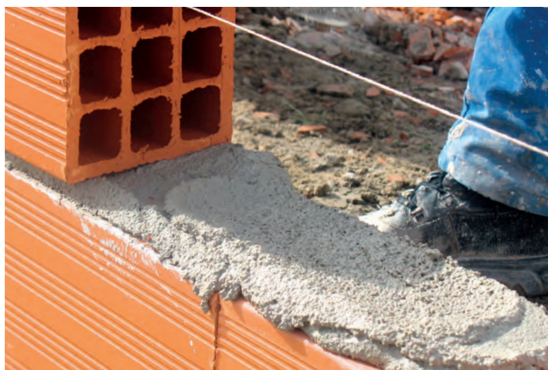
Elevação de pano em alvenaria
