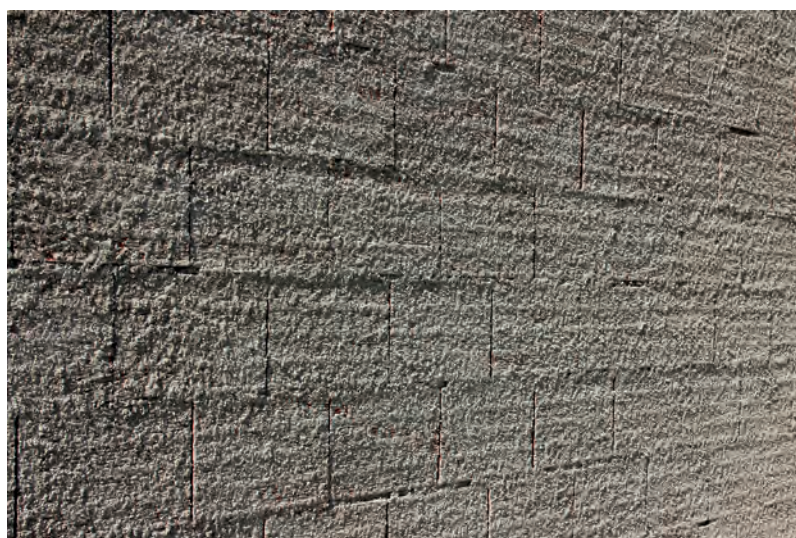
Preparação de suporte com Argamassa de CHAPISCO
