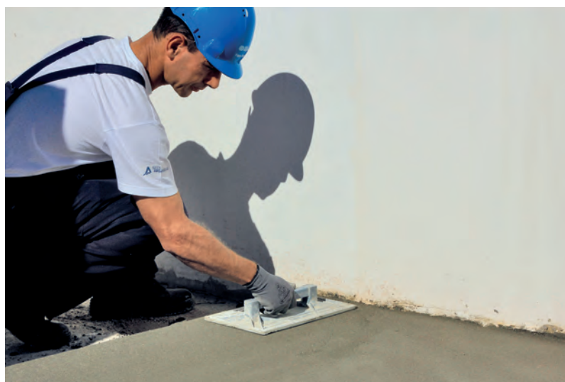
Aplicação da BETONILHA ecoCORK
