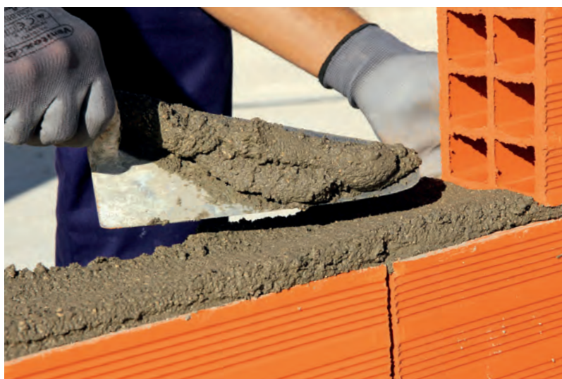
Aplicação da ALVENARIA ecoCORK
